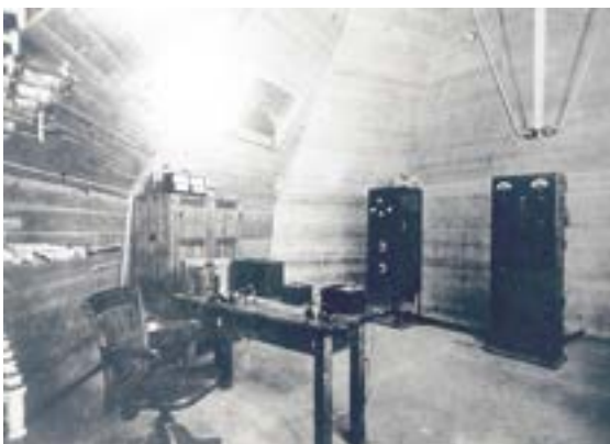
Sala de l'emissora de Ràdio Barcelona a l'Hotel Colón.
